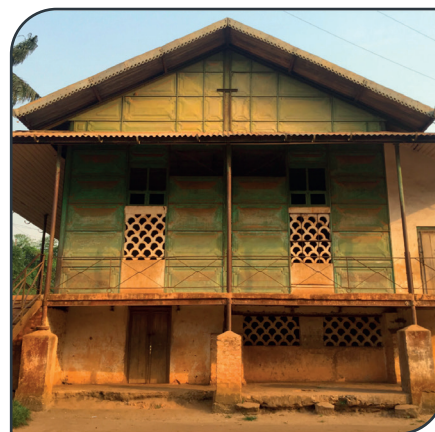
Bâtiment scolaire réalisé par les Forges d'Aiseau à Mbanza-Ngungu (RDC). Photo Dalia Perziani, 2016
