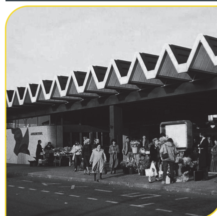
Les coques "M" sur la gare d'Argenteuil (F). Source: Bruno Vignal
