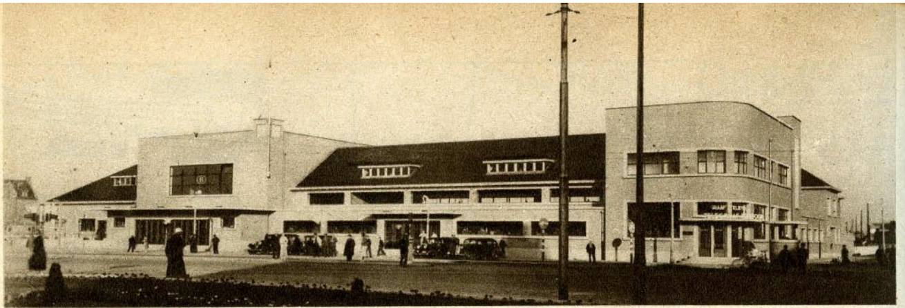
Vue d'ensemble de la nouvelle gare de Blankenberghe. L'entreprise générale comprenant le gros œuvre, le parachèvement et les travaux de menuiserie a été effectuée par Robert Wyckaert, ingénieur-entrepreneur, 62, boulevard Zonsberg, à Gand. On a placé dans la gare neuf cabines téléphoniques étanches au son « Discréta », brevetées S. G. D. G., marque déposée, fabriquée par la S. A. Absorbit, à Haren.
