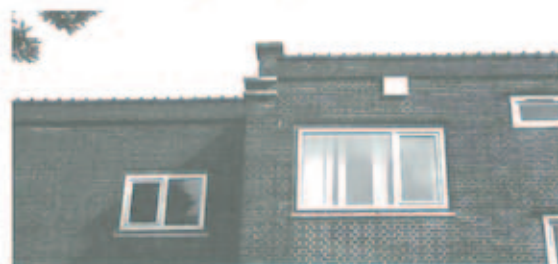
rechts boven Archieffoto noordwestgevel Reserveboezem III. (foto: archief de Nieuwe Unie)
